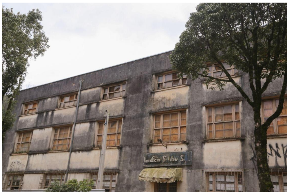
Figura 18 – Vista do prédio onde funcionou o Círculo Operário, 2025.
