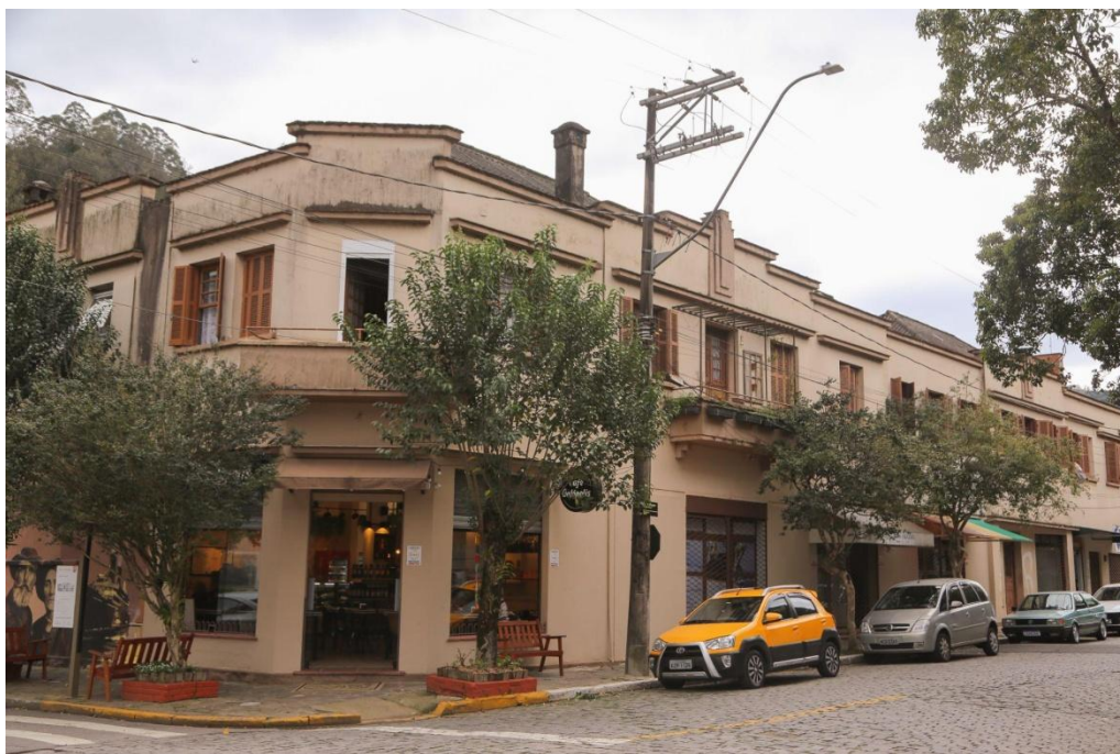
Figura 19 – Vista do prédio onde funcionou a Cooperativa de Consumo, 2025.
